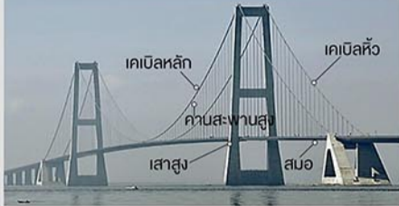
สะพานแขวน Great Belt Bridge ประเทศเดนมาร์ก
