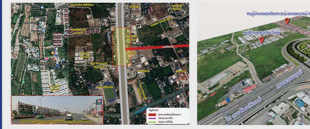
สภาพพื้นที่ปัจจุบันบริเวณทางแยกต่างระดับบริเวณจุดตัดถนนราชพฤกษ์
